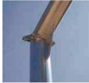
Detalle de la cartela de unión entre el mástil y el brazo.
