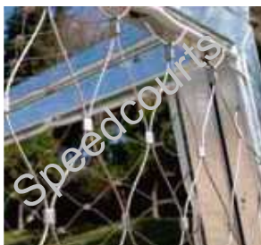
Detalle del trenzado de la red y su fijación a los postes
